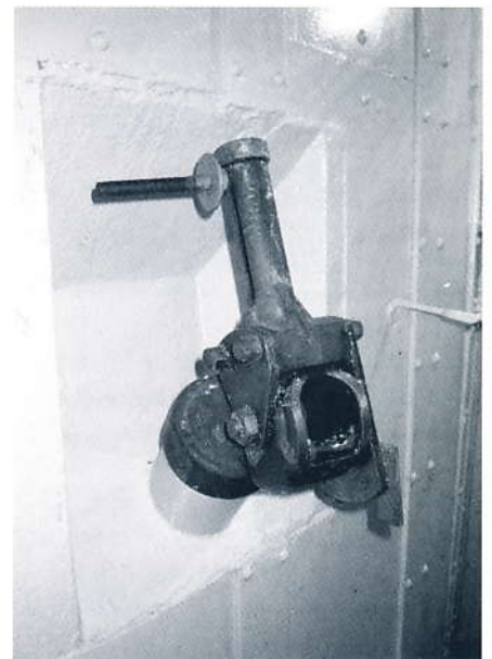
Overalt i Maginotlinien forekommer disse "håndgranatudstødeapparater". Apparatet bestod af et rør med et stempel, der kunne skubbe en standard-håndgranat ned i den foranliggende Fosse Diamant. På fotoet er stemplet knækket på samme måde som et jagtgevær. Håndgranaten blev afsikret og placeret i åbningen, hvor en fjederplade holdt sikringsbøjlen på plads. Først når man ved hjælp af stemplet trykkede håndgranaten gennem røret og ud i det fri, blev sikringsbøjlen frigjort, og håndgranaten bragt til sprængning.
