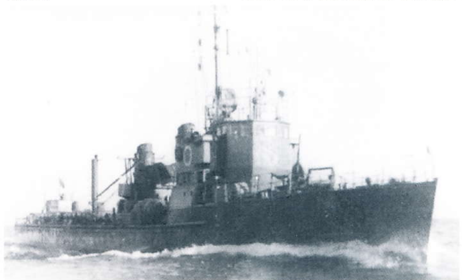
Hvalen i tysk tjeneste under navnet TFA 5. TFA stod for Torpedofangboot Ausland. Bemærk kranen på agterdækket, der blev brugt til indtagning af torpedoer.
