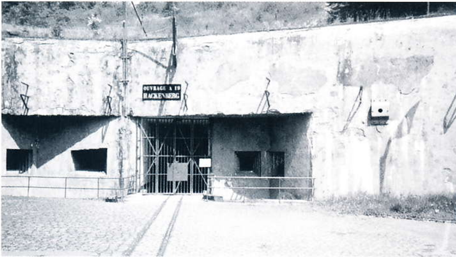
Entre Munition. På begge sider af indkorsten, hvor tog med ammunition og andre forsyninger kunne køre direkte ind i fortet, er der skydeskår til maskingevær og panserværnskanoner. Over skydeskårene er der i muren beslag til en radioantenne. Trådløs radio blev kun anvendt som sekundært signalmiddel, idet alle Maginotliniens anlæg var koblet sammen med et omfattende, nedgravet, telefonnet.
