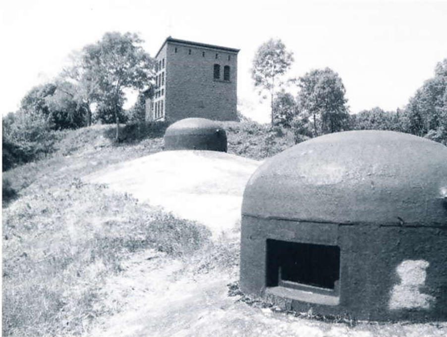
Blok 12 på toppen af den 343 meter høje bakke. I baggrunden kapellet. Herfra er der en fremragende udsigt over området, og der er let adgang til Hackenbergs forskellige anlæg.
