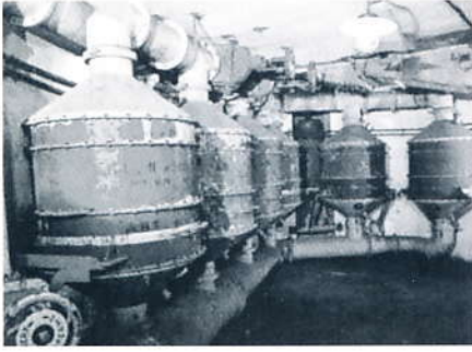
I tilfælde af et gasangreb blev alt luft sendt gennem disse store filtratorer, inden den blev sendt rundt i det store fort. Filtrene var fyldt med aktivt kul og virkede på helt samme måde som filtratorer på moderne ABC-masker. Selve filtertønden kunne udskiftes individuelt. Hver kampblok har egne filteranlæg.
