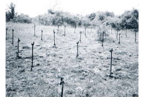
Pas på, der er pigtrådshindringer overalt på fortets overside. I alt blev der anvendt 40.200 m 2 pigtrådshindringer i forbindelse med Hackenberg, og ikke ret meget af det er nogensinde fjernet igen. Pigtråden er nu meget rusten og mange steder skjult i højt græs og ungskov. De lange pæle er ikke de farligste, men imellem dem er der placeret små korte, tilspidsede jernpæle. De er til gengæld livsfarlige.
